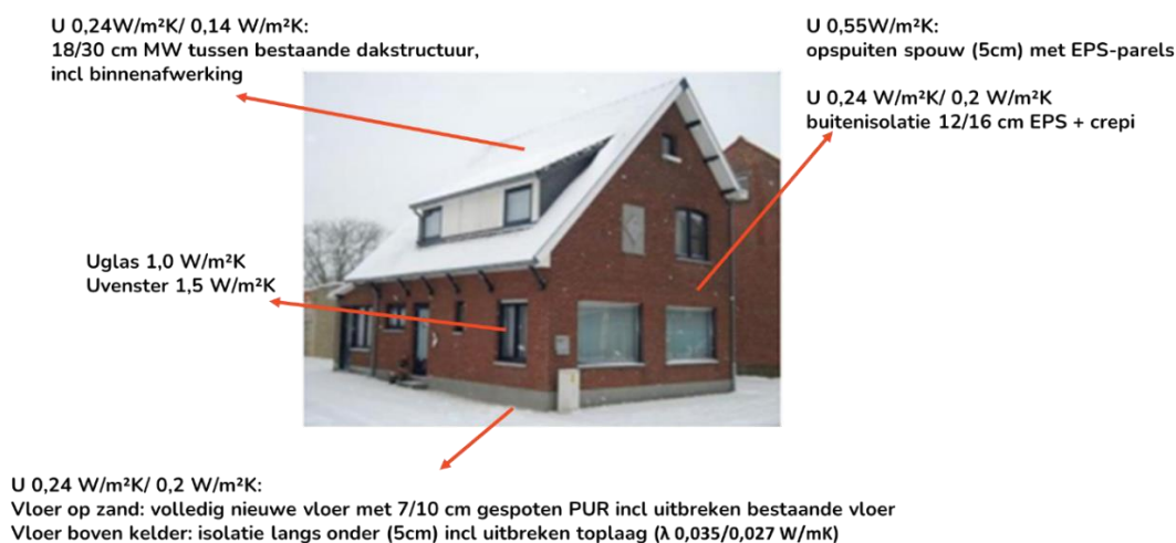
Figuur 4: Verschillende isolatiemaatregelen van de typewoning
